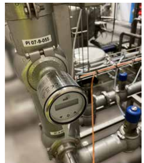
Seli STS im Einsatz
